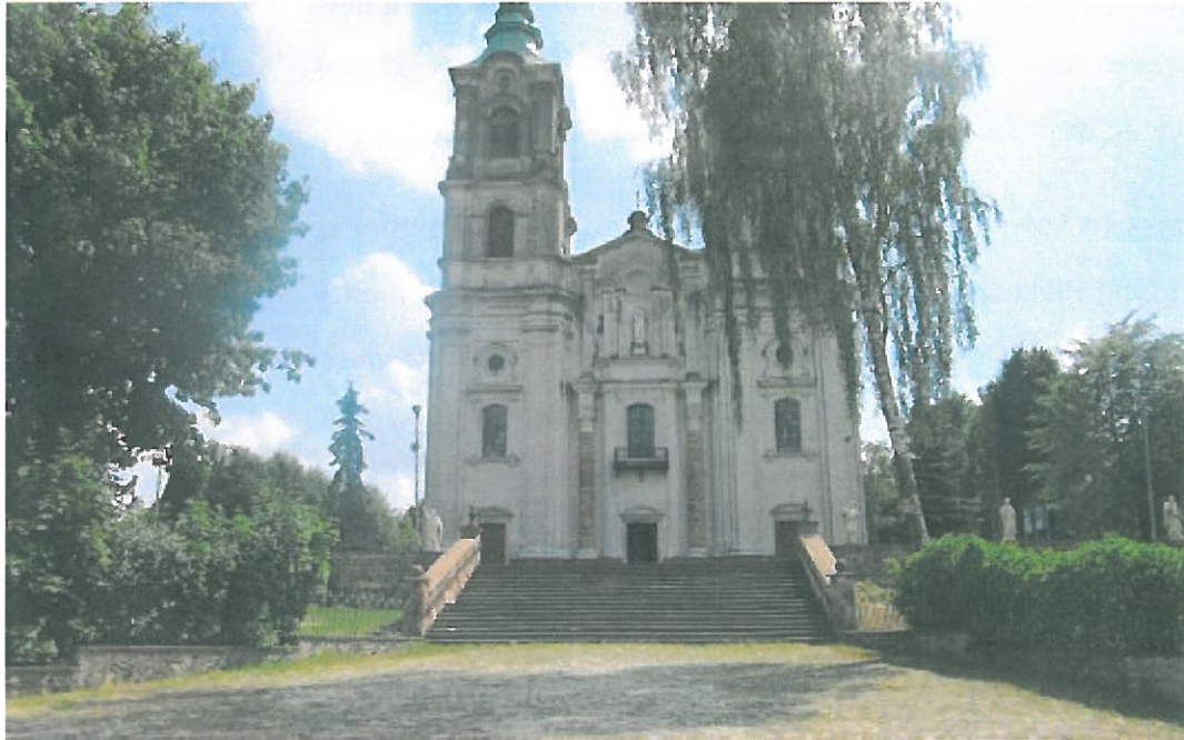
Zdjęcie 2. Schody prowadzące do Sanktuarium
