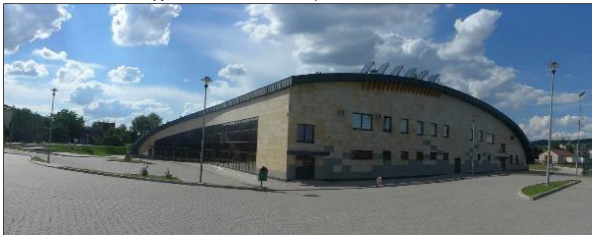
Zdjęcie 1 Hala widowiskowo-sportowa „Pod Basztami”
