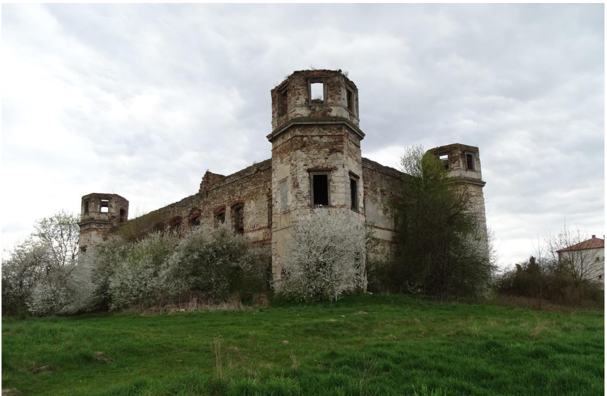
Ruina pałacu Tarłów w Podzamczu – widok na elewację północną i wschodnią, 2023 r.
