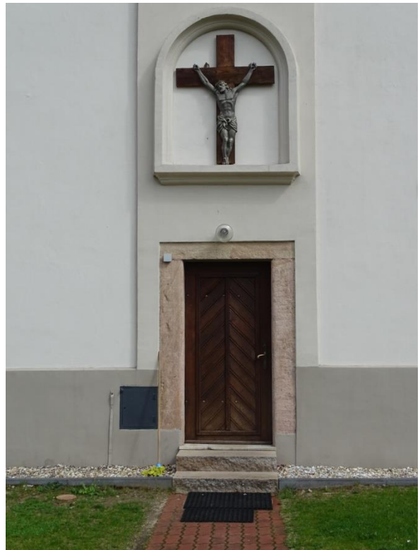
Wejście boczne – południowe
