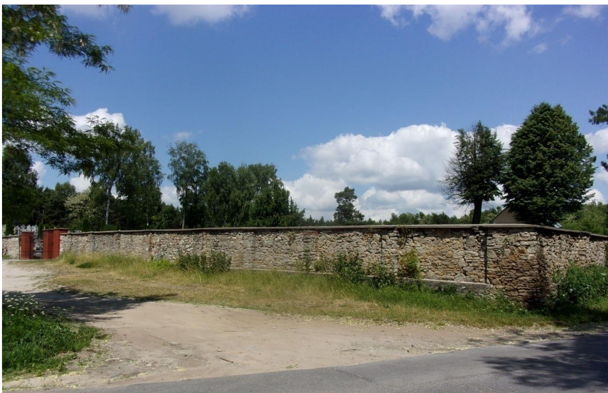
Fragment ogrodzenia cmentarza z bramą główną
