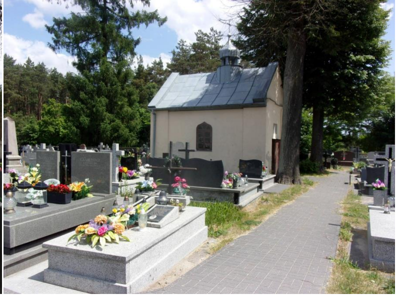
Widok na elewację boczną
